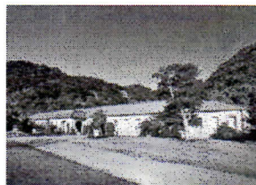
旧集成館機械工場
